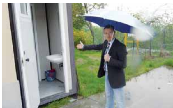
Fabrizio Vercelli mostra le condizioni del bagno pubblico
