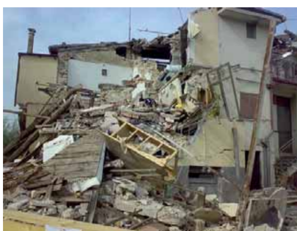
Gli effetti del terremoto sono ancora visibili
