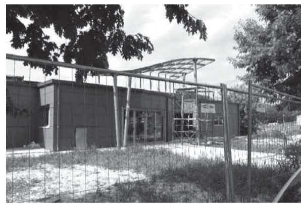
I lavori alla nuova scuola materna
