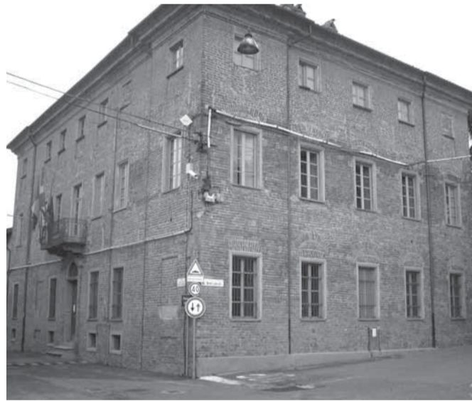
Palazzo Ellena, sede provvisoria del Comune
