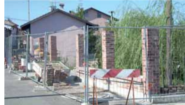
Il muretto in costruzione a Piazza
