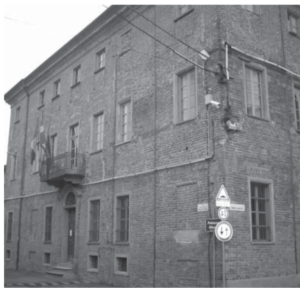
Palazzo Ellena, sede provvisoria del Municipio
