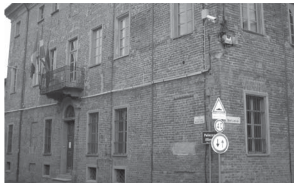
Palazzo Ellena, sede provvisoria del municipio
