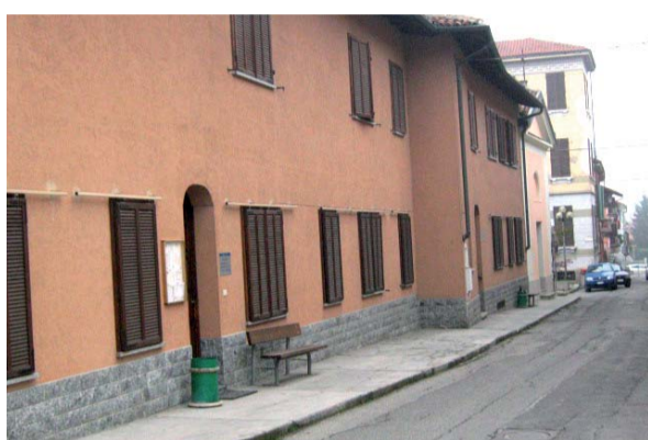
L'edificio dell'ex Cottolengo
