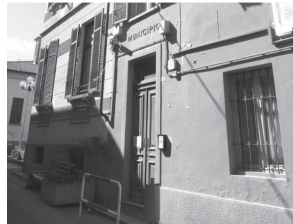
L'ingresso del palazzo municipale
